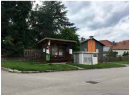
Ambach (bei EVN – Trafo)
