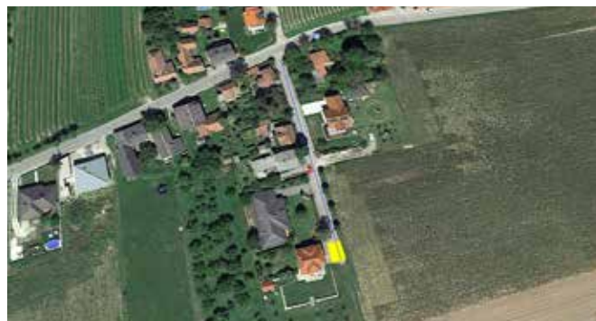
Unterwölbling Regenwasserkanal und Umkehrplatz
