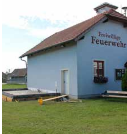
Zubau FF-Haus Hausheim: Erste Arbeiten sind bereits in Gange
