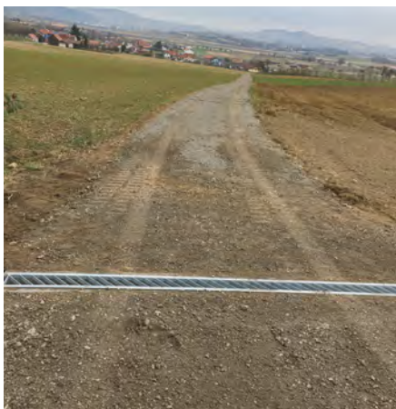
Neu verbaute Wasserspule in Landersdorf
