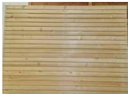
Foto Ansicht Seitenwände: Die Wände werden in Rhomboidschalung (Ansichtsfoto) aus Lärche ausgeführt – natürlich und modern.
